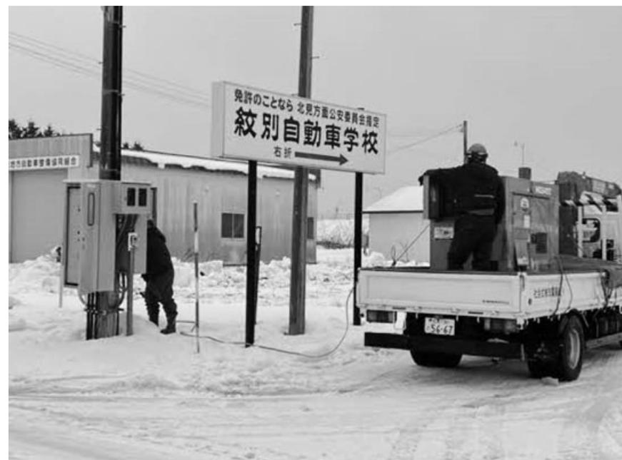
トラックに積載した可搬式発電設備を巡回させ、制御盤への電源供給を行いマンホールポンプを起動させ汚水流下機能を確保
