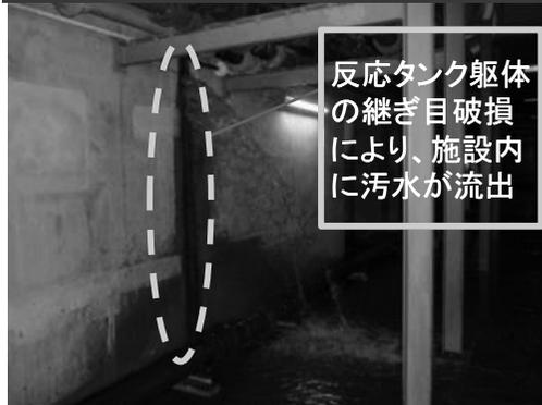
反応タンク躯体の継ぎ目破損により、施設内に汚水が流出
