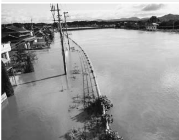
決壊した阿武隈川と周辺地域(須賀川市内)
