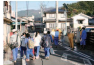
通学路の除染 2011. 10. 27 (川俣町)
