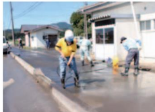
除染作業 2011. 9. 18 (南相馬市)
