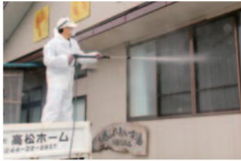
除染作業 2011. 9. 11 (南相馬市)
