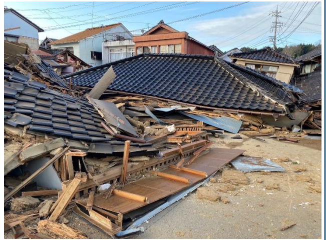
石川県能都町の被災状況
