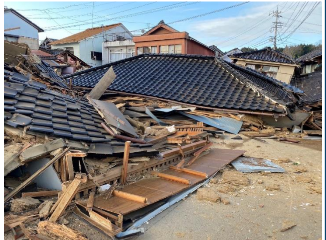
石川県能都町の被災状況
