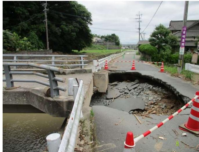
道路兼用護岸崩壊・陥没（大字岩本）
