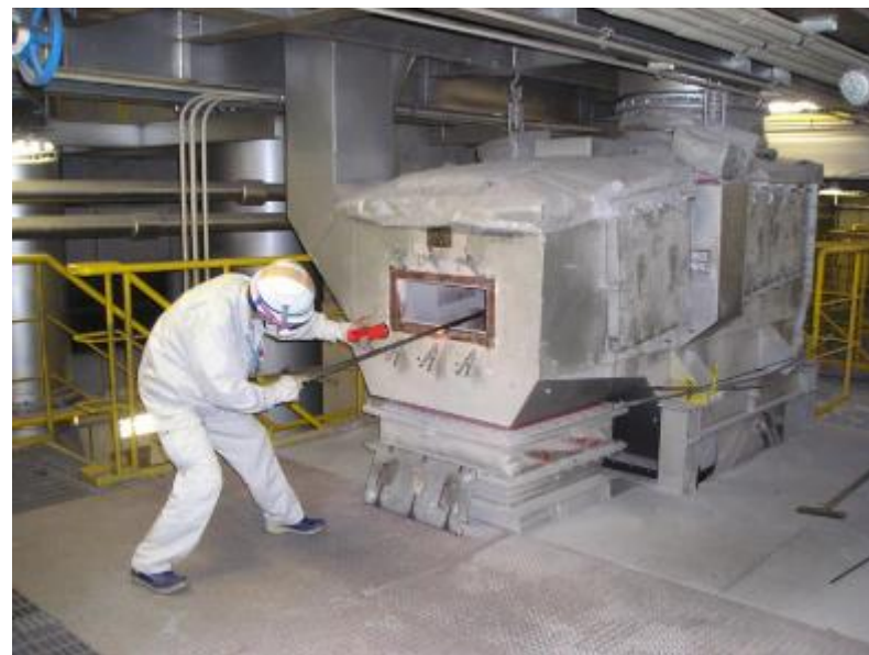
不燃物撤去作業(豊島清掃工場)
