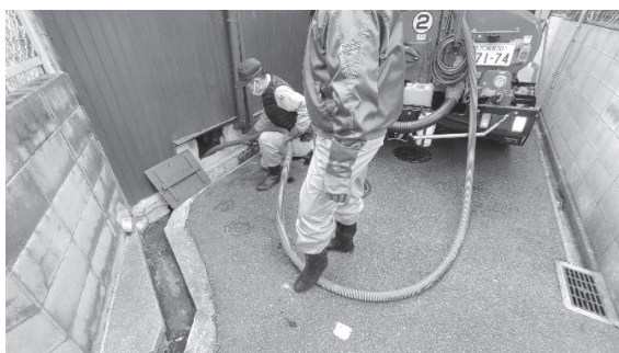
ホースを固定しながら吸引していく
