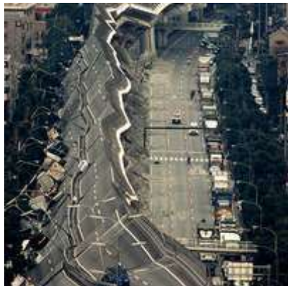
（都市部の直下型地震では 建物の倒壊により大きな被害）
